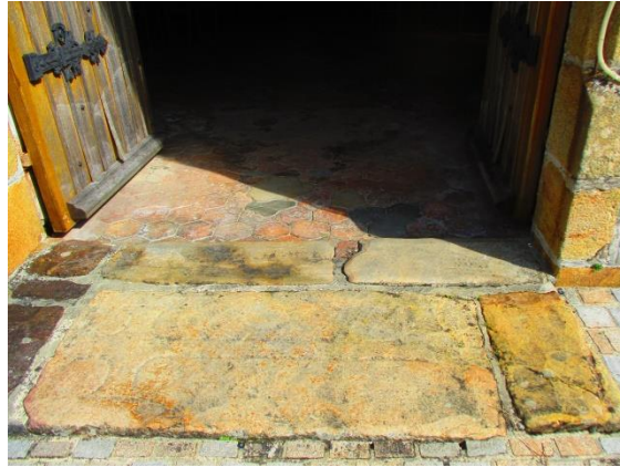
Les dalles funéraires en grès, gravées de croix, servant de marches de seuil.
