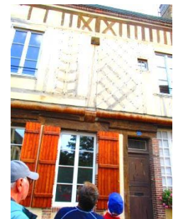
Maison à pans de bois
